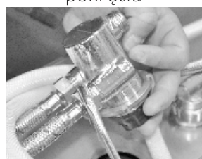
6. odkręcenie przyłącza wody
