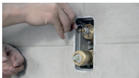
15 | zamontuj ogranicznik liczby funkcji BOXa, jeśli chcesz mieć mniej niż 3 źródła wypływu wody
