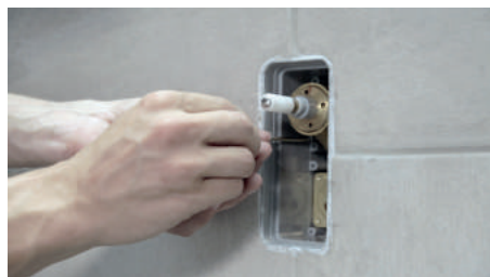
13 | przykręć przełącznik funkcji
