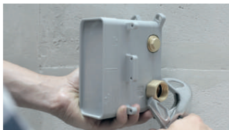
1 | przykręć złącza kątowe do BOXa
