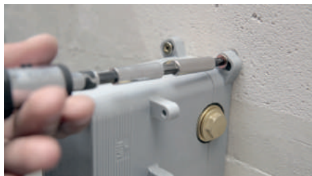
3 | przykręć BOX do ściany
