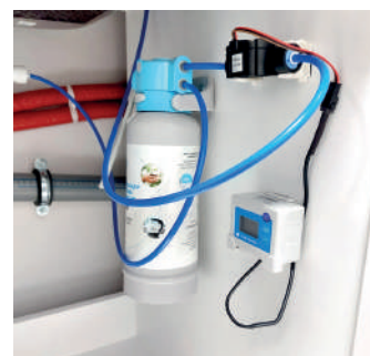
Exemple de lieu de fixation de l'indicateur
