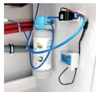
Przykładowe miejsce zamocowania wskaźnika
