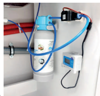
A kijelző felerősítési helyének példája
