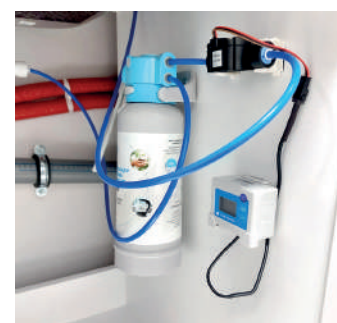
Przykładowe miejsce zamocowania wskaźnika
