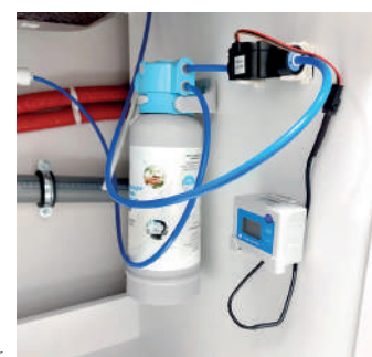
Exemple de lieu de fixation de l'indicateur
