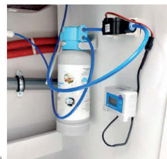
A kijelző felerősítési helyének példája
