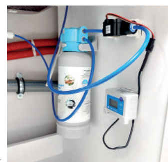
Exemple de lieu de fixation de l'indicateur
