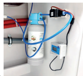
Beispiel für die Montage der Anzeige
