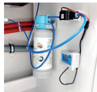
Exemplu de loc de montare a indicatorului
