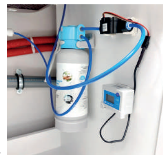
Exemple de lieu de fixation de l'indicateur
